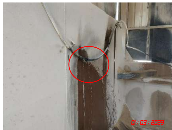
ระบบสเปรย์น้ำบริเวณจุดกำเนิดฝุ่นละอองภายในโรงไม้หิน
