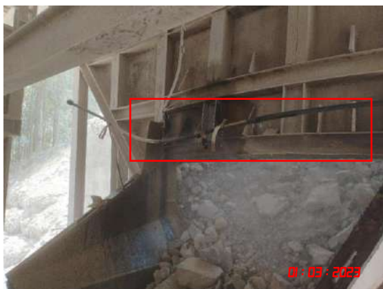
ระบบสเปรย์น้ำบริเวณจุดกำเนิดฝุ่นละอองภายในโรงไม้หิน
